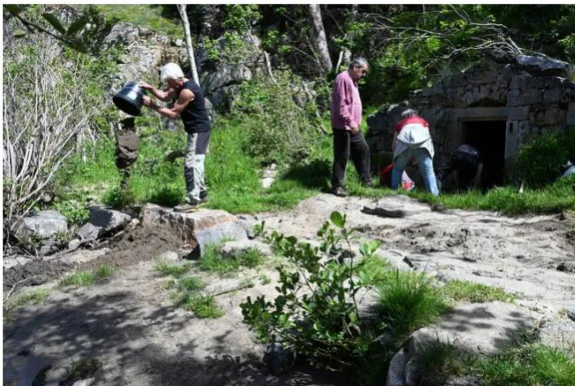
Le sable accumulé autour de la source a été évacué à la pelle et au seau. © Céline DEMARS
