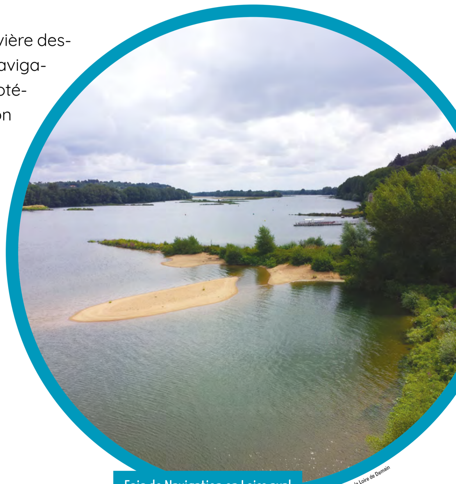
Épis de Navigation en Loire aval
