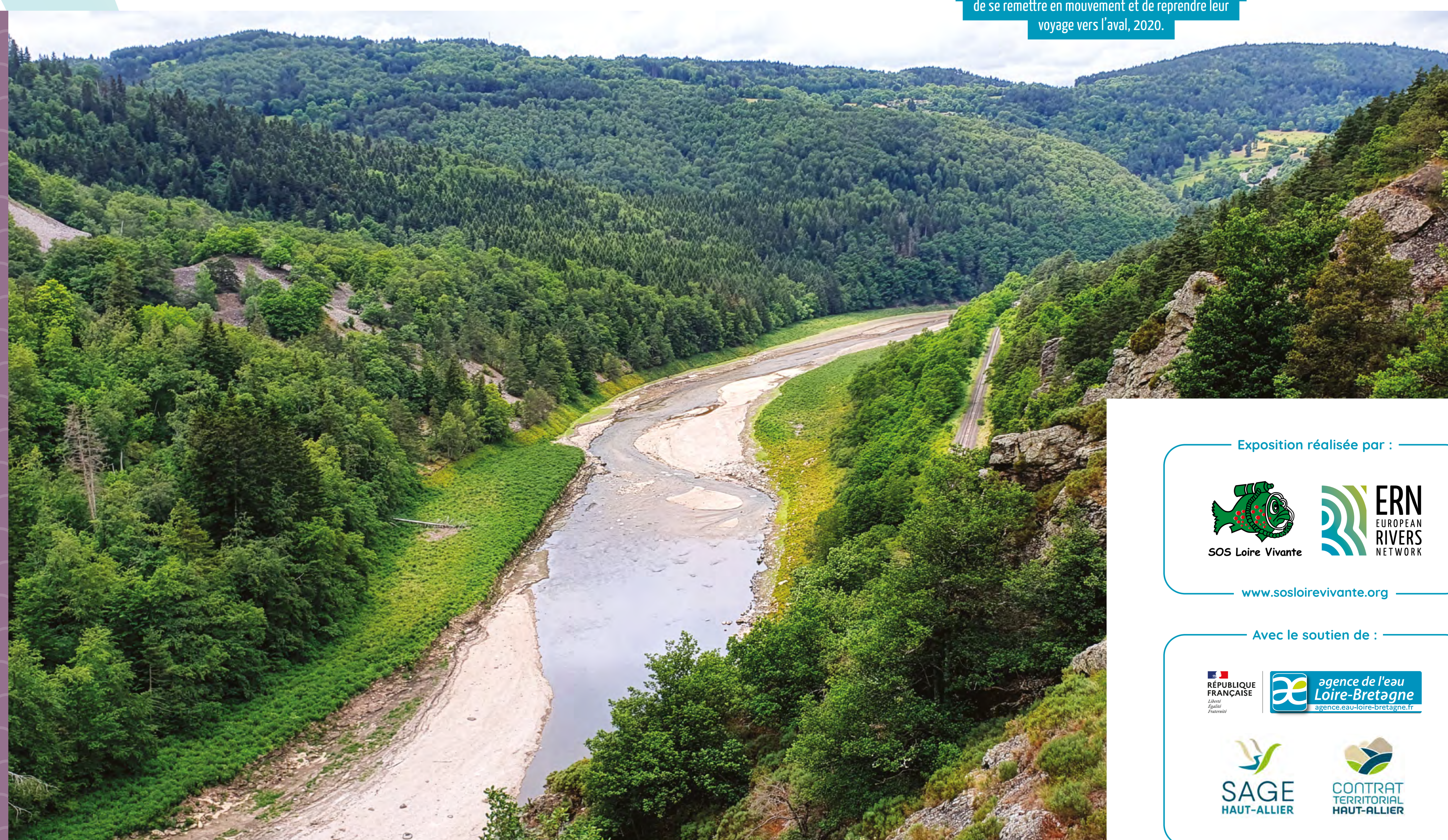
Ancienne retenue du barrage de Poutès (43). La suppression de la retenue a permis aux sédiments de se remettre en mouvement et de reprendre leur voyage vers l'aval, 2020.
