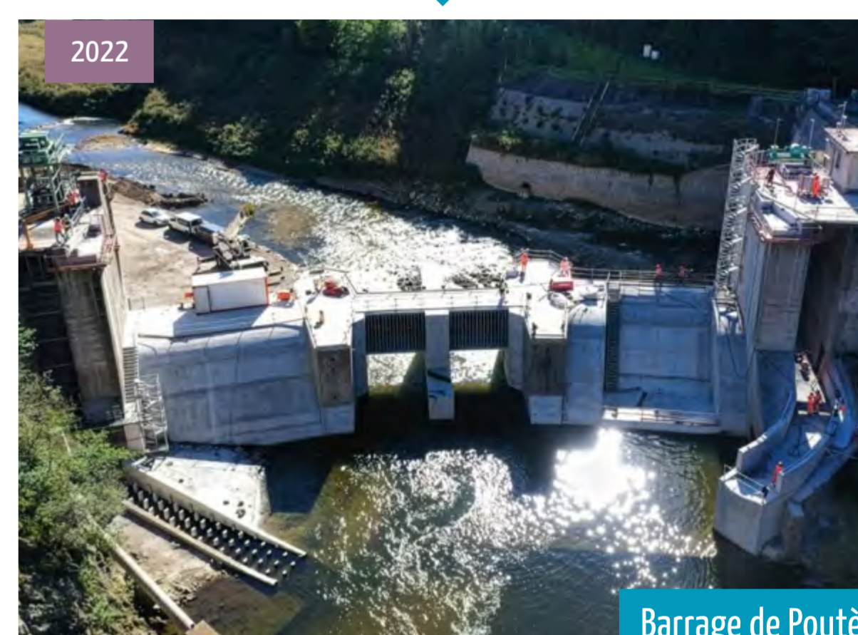
Barrage de Poutès (43) avant et après reconfiguration
